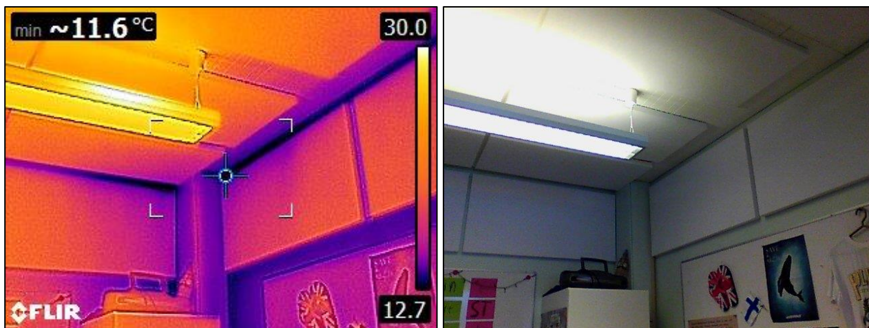
Kuva 2.3. Lämpökuva ulkoseinän ja yläpohjan liitosalueelta: lämpötilaindeksi on 63.
