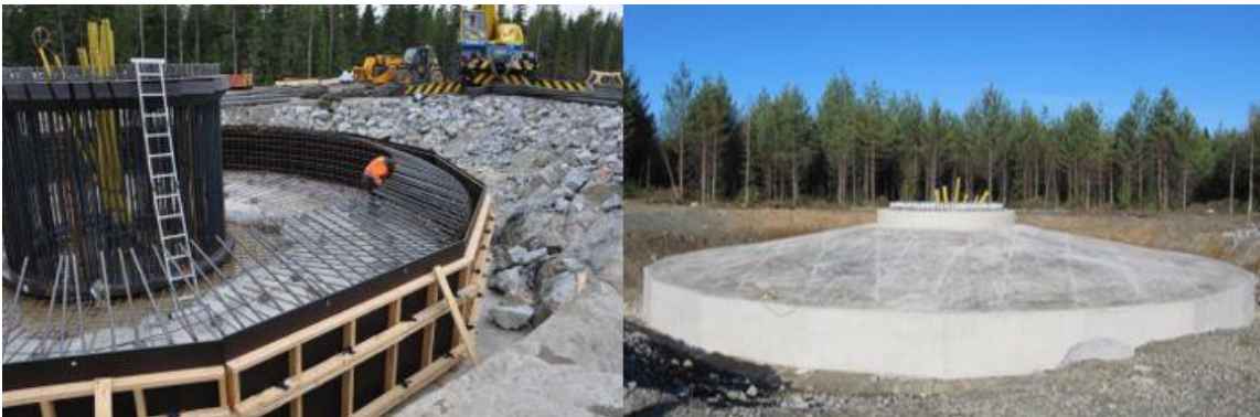
Kuva 9.11. Tuulivoimalan perustusten rakentamista (Leila Väyrynen, FCG).
