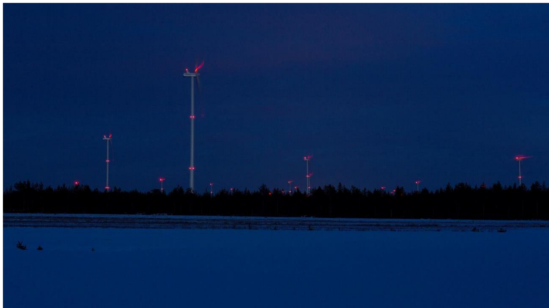
Kuva 9.4. Kiinteät punaiset lentoestevalot (Ville Suorsa, FCG).
