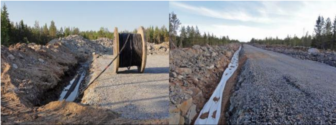
Kuva 9.10. Maakaapelit upotetaan huoltoteiden yhteyteen (Ville Suorsa, FCG).
