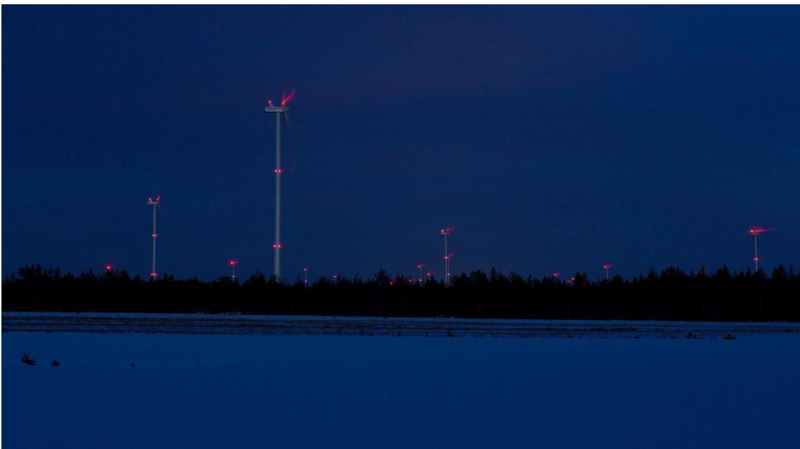
Kuva 9.4. Kiinteät punaiset lentoestevalot (Ville Suorsa, FCG).
