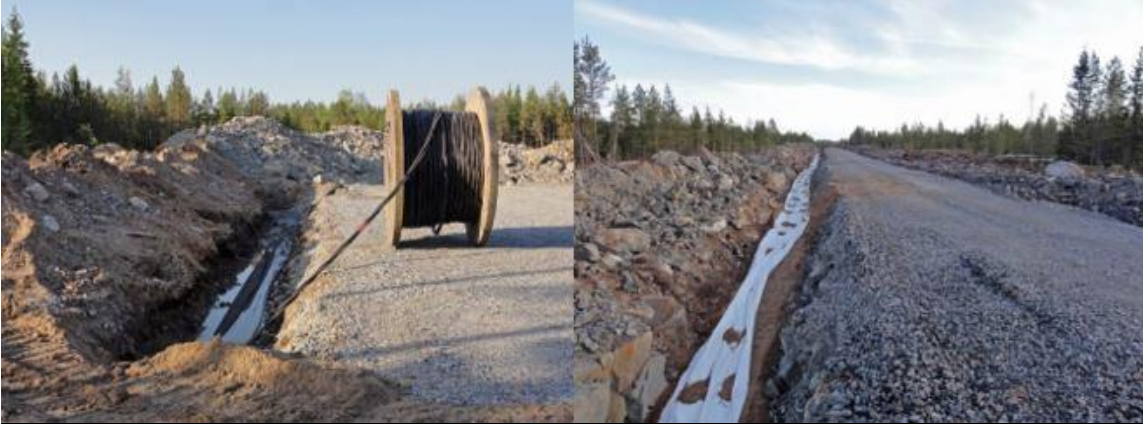
Kuva 9.10. Maakaapelit upotetaan huoltoteiden yhteyteen (Ville Suorsa, FCG).
