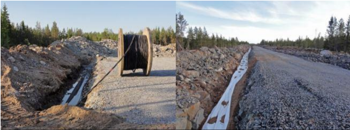
Kuva 9.10. Maakaapelit upotetaan huoltoteiden yhteyteen (Ville Suorsa, FCG).
