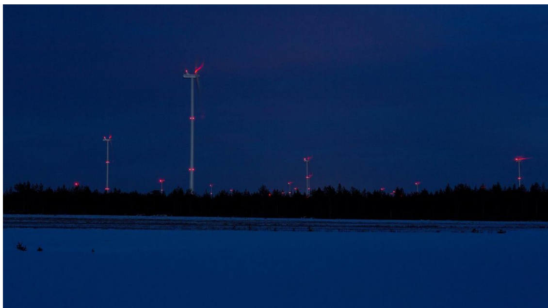
Kuva 9.4. Kiinteät punaiset lentoestevalot (Ville Suorsa, FCG).
