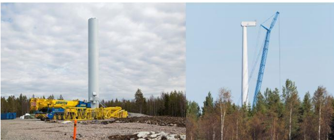
Kuva 9.12. Tuulivoimalan kokoamista (Ville Suorsa, FCG).
