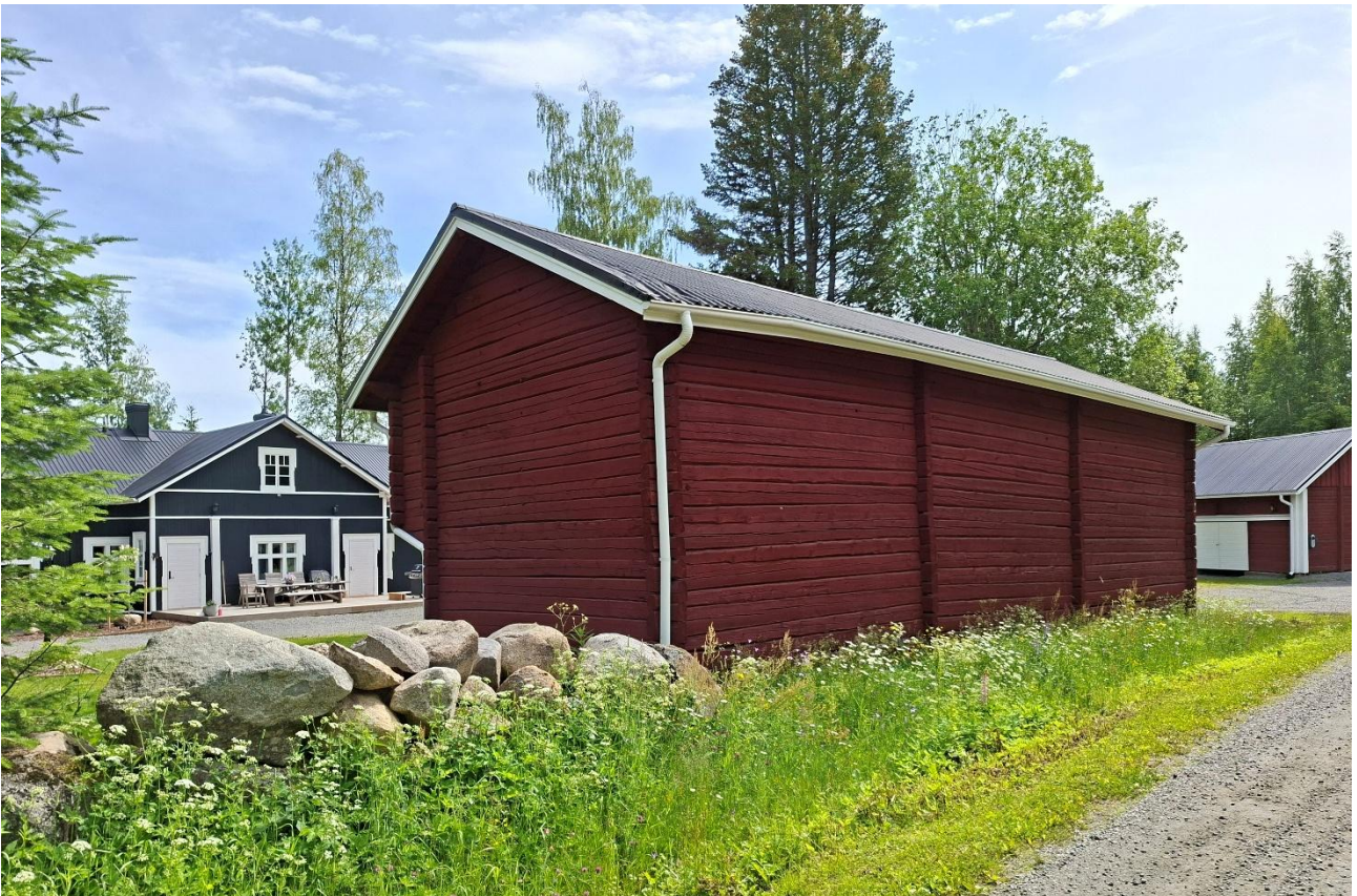
Kuva 26. Pihan aitta. Taustalla päärakennus ja etualalla vasemmalla luonnonkivistä kasattua vallia.
