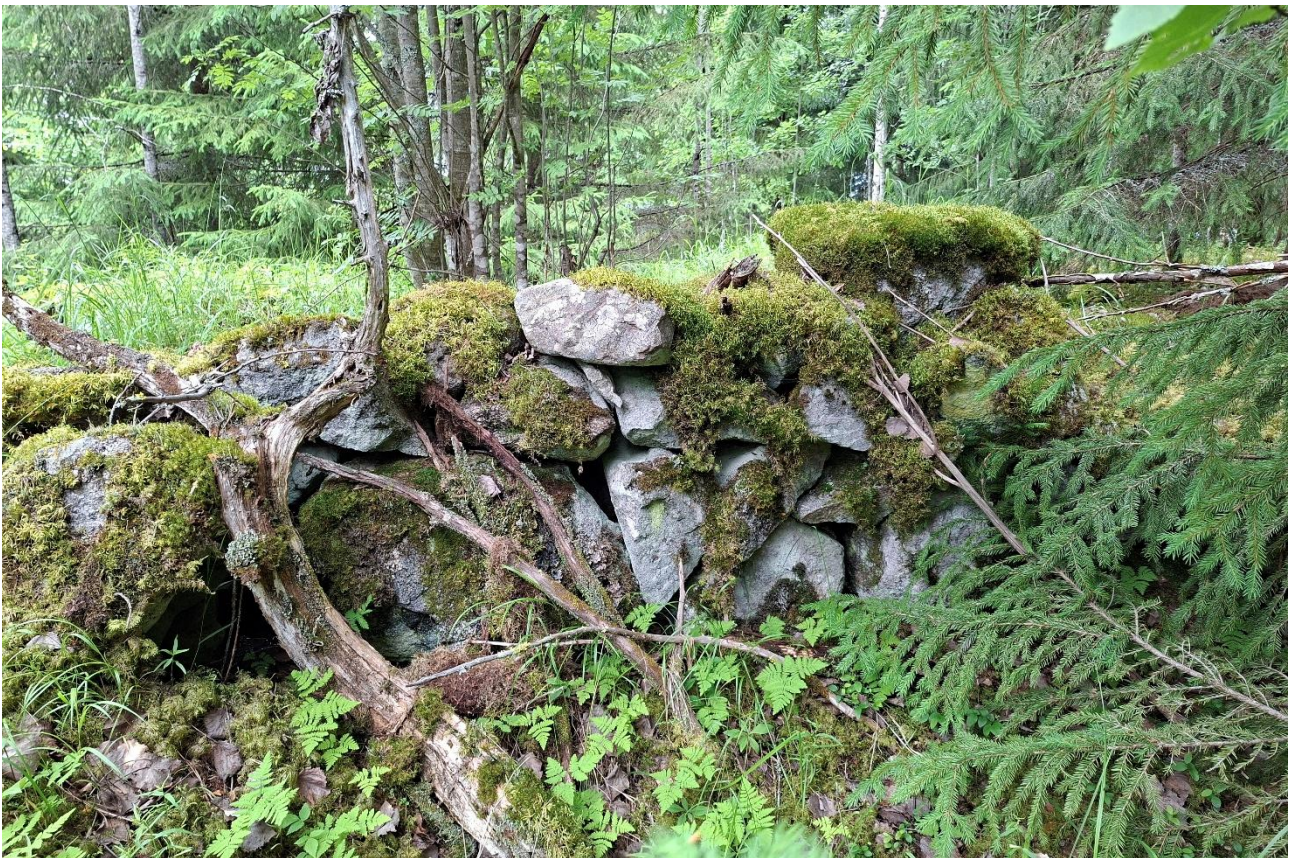
Kuva 19. Tontin kaakkoisreunassa havaittu kivilatomus.
