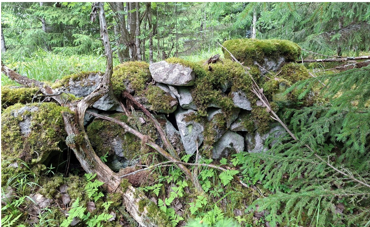
Kuva 32. Kuva latomuksen pohjoispäästä. Kuva luoteeseen.
