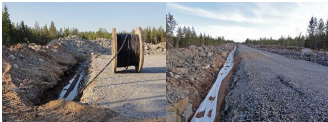
Kuva 9-10. Maakaapelit upotetaan huoltoteiden yhteyteen (Ville Suorsa, FCG).
