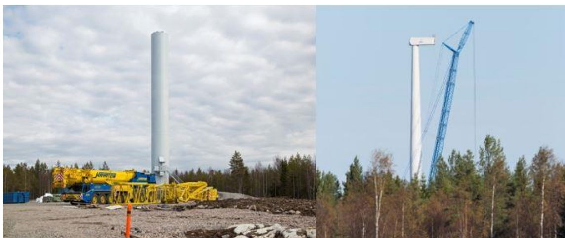
Kuva 9-12. Tuulivoimalan kokoamista (Ville Suorsa, FCG).
