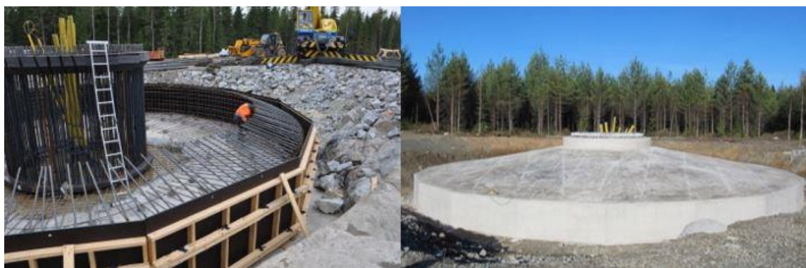
Kuva 9-11. Tuulivoimalan perustusten rakentamista (Leila Väyrynen, FCG).
